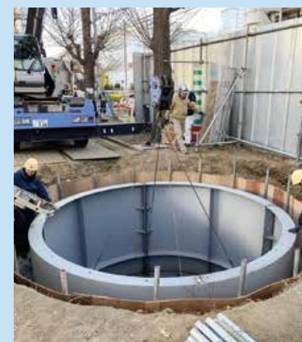
富家町公園防火水槽補強工事 平成31年度 40m 3 級貯水槽設置工事(縦円筒形) 道路横の住宅街近傍の公園での工事
