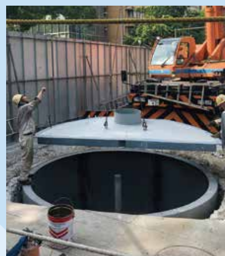
横浜公園北側防火水槽補強工事 平成31年度 100m 3 級貯水槽設置工事(縦円筒形) 緊急車両等通行路での工事
