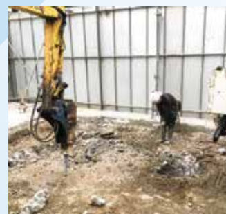
1 既設頂板の撤去
