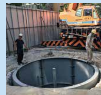
8 側版設置完了
