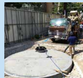
11 流動化処理土充填工事
