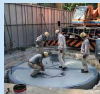
10 底板・頂板設置完了
