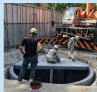
9 底板・頂板工事
