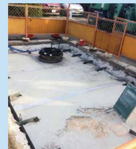
富岡地区防火水槽補強工事 平成30年度 40m 3 級貯水槽設置工事(角形) 民地内の水槽を補強した工事
