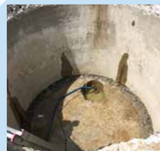
2 頂板撤去終了
