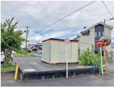
①施工前の防火水槽
