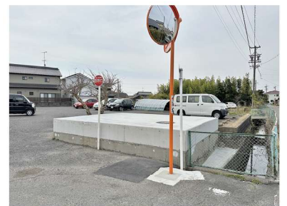
⑨タンクインタック完成
