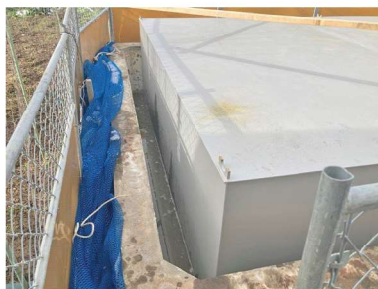
⑧既設防火水槽と鋼製タンクの間 流動化処理土を流し込む様子
