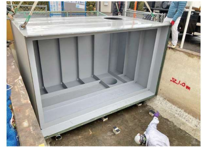
③2分の1 鋼製タンク設置
