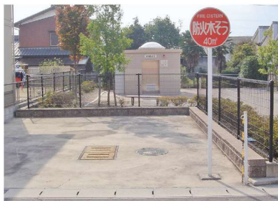
地下式防火水槽
