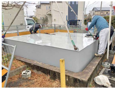
⑤2分の2 鋼製タンク設置
