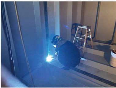
⑥鋼製タンク内部溶接
