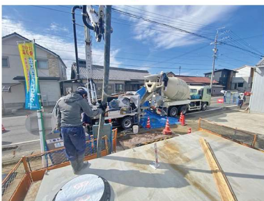
⑦既設防火水槽と鋼製タンクの間 流動化処理土を流し込む様子
