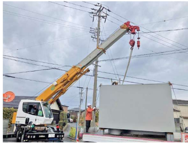
②2分の1 防火水槽搬入時
