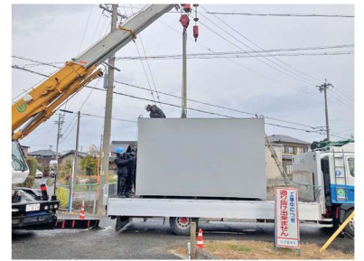
④2分の2 防火水槽搬入時
